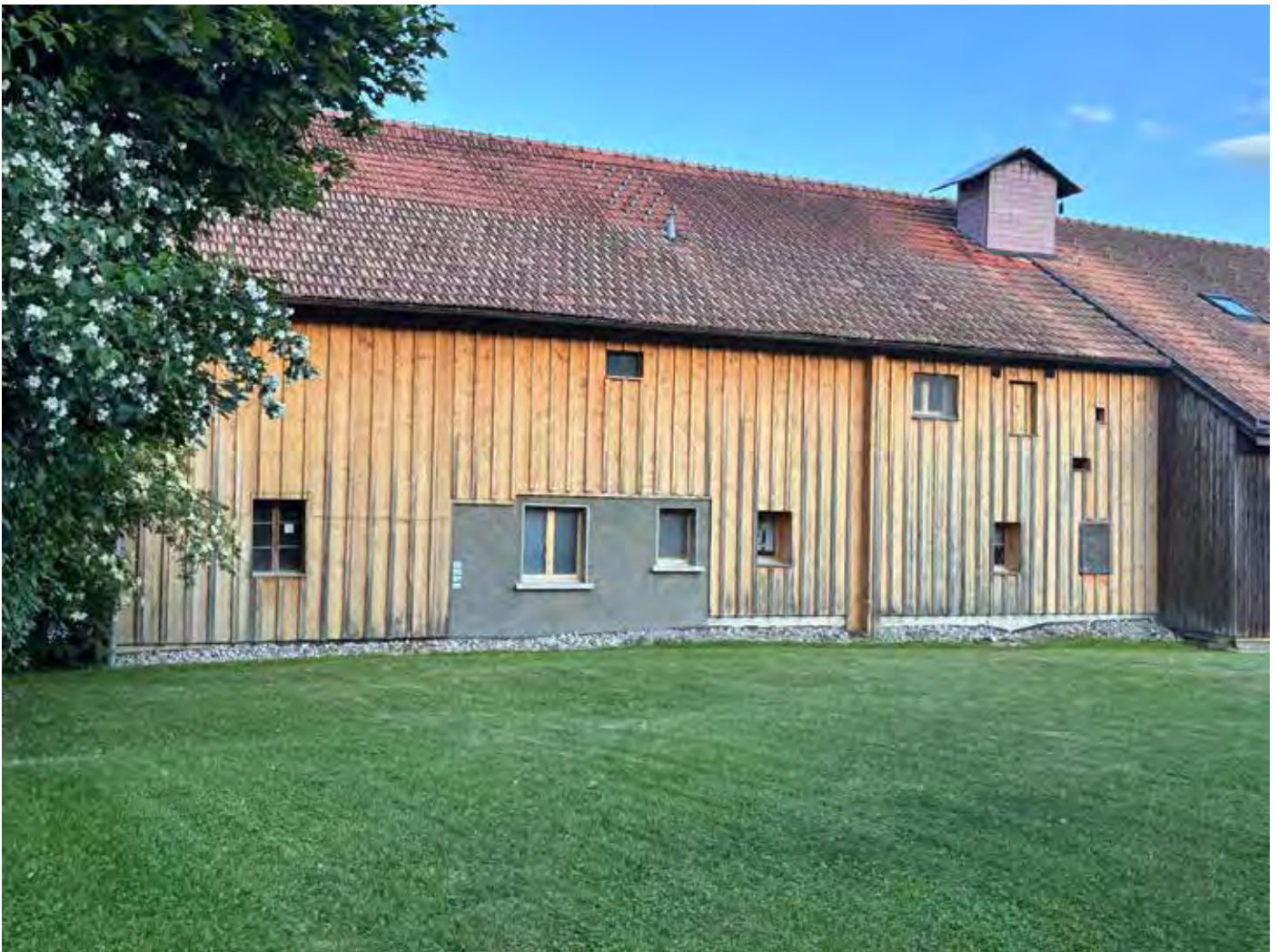
Façade arrière (sans accès)
